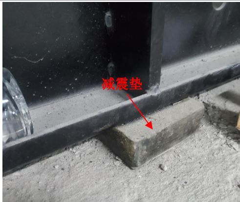
设于地下室的噪声设备采取的噪声防治措施情况
