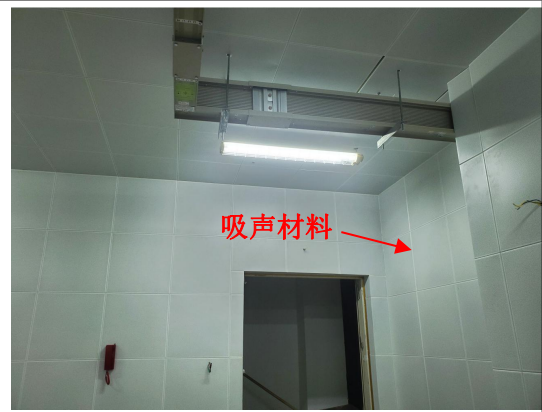
设于地下室的噪声设备采取的噪声防治措施情况
